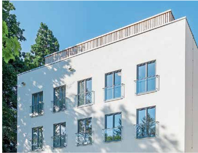
Die Dengler-Klinik in Baden-Baden ist Vorreiter in Sachen mehrstöckiger Holzgesundheitsbau.
